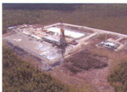
Западный Салым. Обустройство куста
