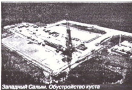
Западный Салым. Обустройство куста
