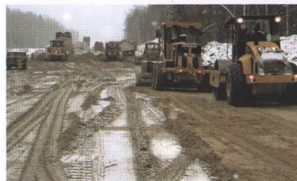
ЗАПАДНЫЙ САЛЫМ. ОБУСТРОЙСТВО КОРИДОРА КОММУНИКАЦИЙ
